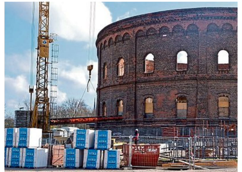
In den Gasometer auf dem Holzplatz soll das neue Raumflugplanetarium einziehen. Auch hier führt die Corona-Krise bislang nicht zum Stillstand.
