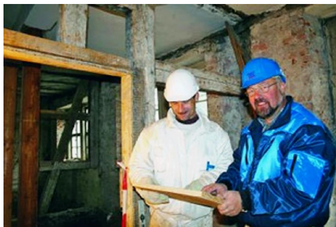
Meister Matthias Süß (re.) und Facharbeiter Heiko Klee besprechen die nächsten Aufgaben bei der Sanierung des Fachwerkes. Foto: Gerhardt -
